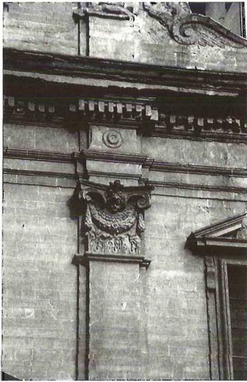
Figure 7 Bernardo Buontalenti, detail of Facade, Sta. Trinità, Florence. Photo: Alina Payne.
