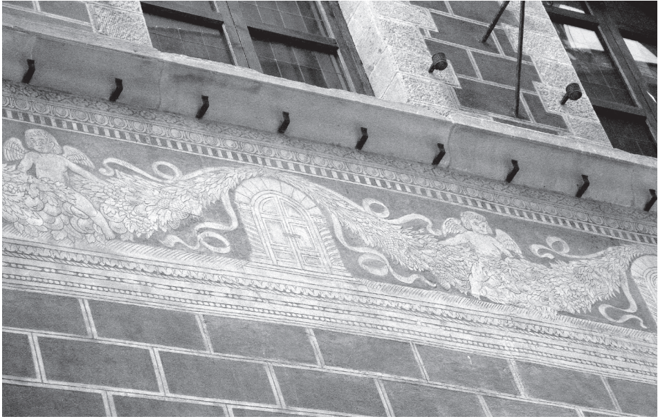
15.6 Detail of sgraffito decoration, Palazzo dell'Arte della Seta, Florence, fifteenth century.
